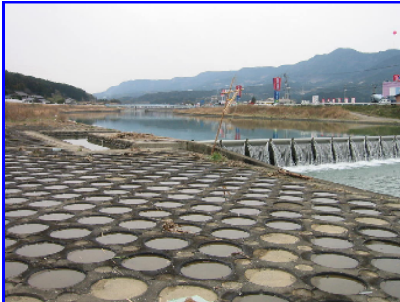
有田川1号堰（上水道取水地点）
